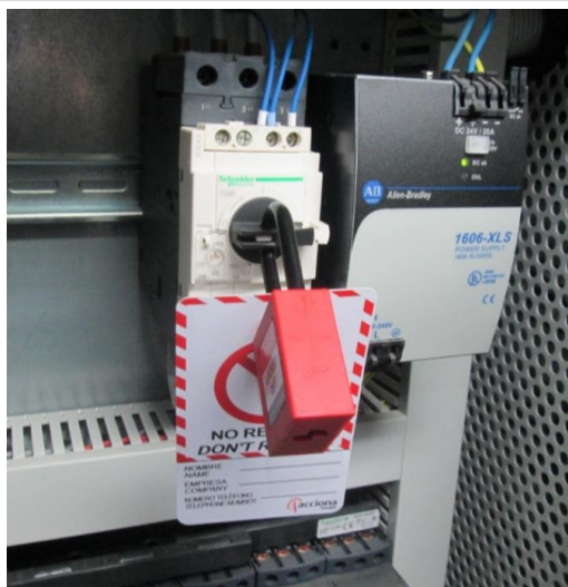
Consignación del magnetotérmico abierto, una vez descubierto el agujero/Lock out Tag out in Circuit Breaker opens once the hole is available.
