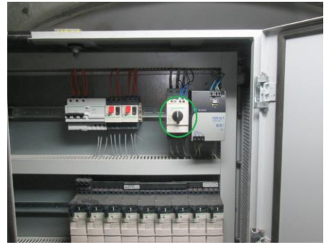
Habitáculo del armario Top abierto. Sobre la imagen el magnetotérmico Q100/Top cabinet open. In the picture, the circuit breaker Q100 is higlighted
